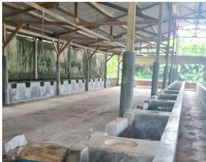
Gambar 2. Kondisi Kandang Sapi Eksisting
