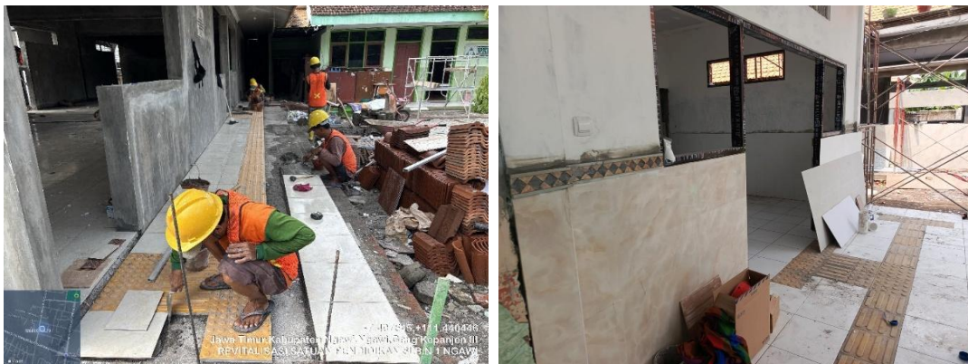
Gambar 4. Proses pelaksanaan Kontruksi Pekerjaan Sarana Ruang Kelas dan Jalur Ramp
