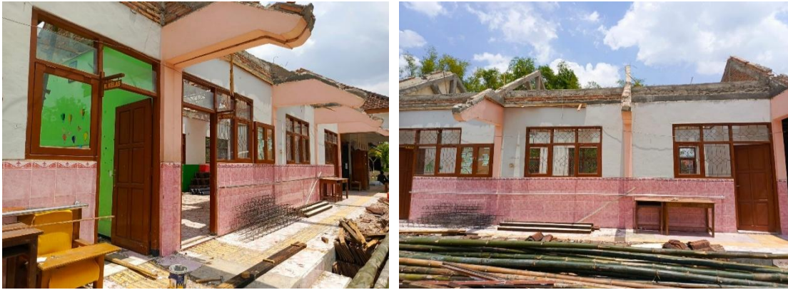
Gambar 3. Kondisi Awal Lokasi Pembangunan Sarana dan Prasarana
