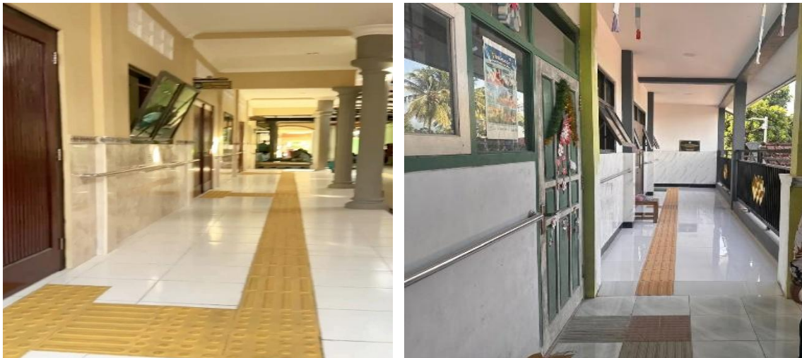
Gambar 8. Dokumentasi Pekerjaan Akhir Aksesibilitas Ruang Kelas dan Hand Railing Selasar
